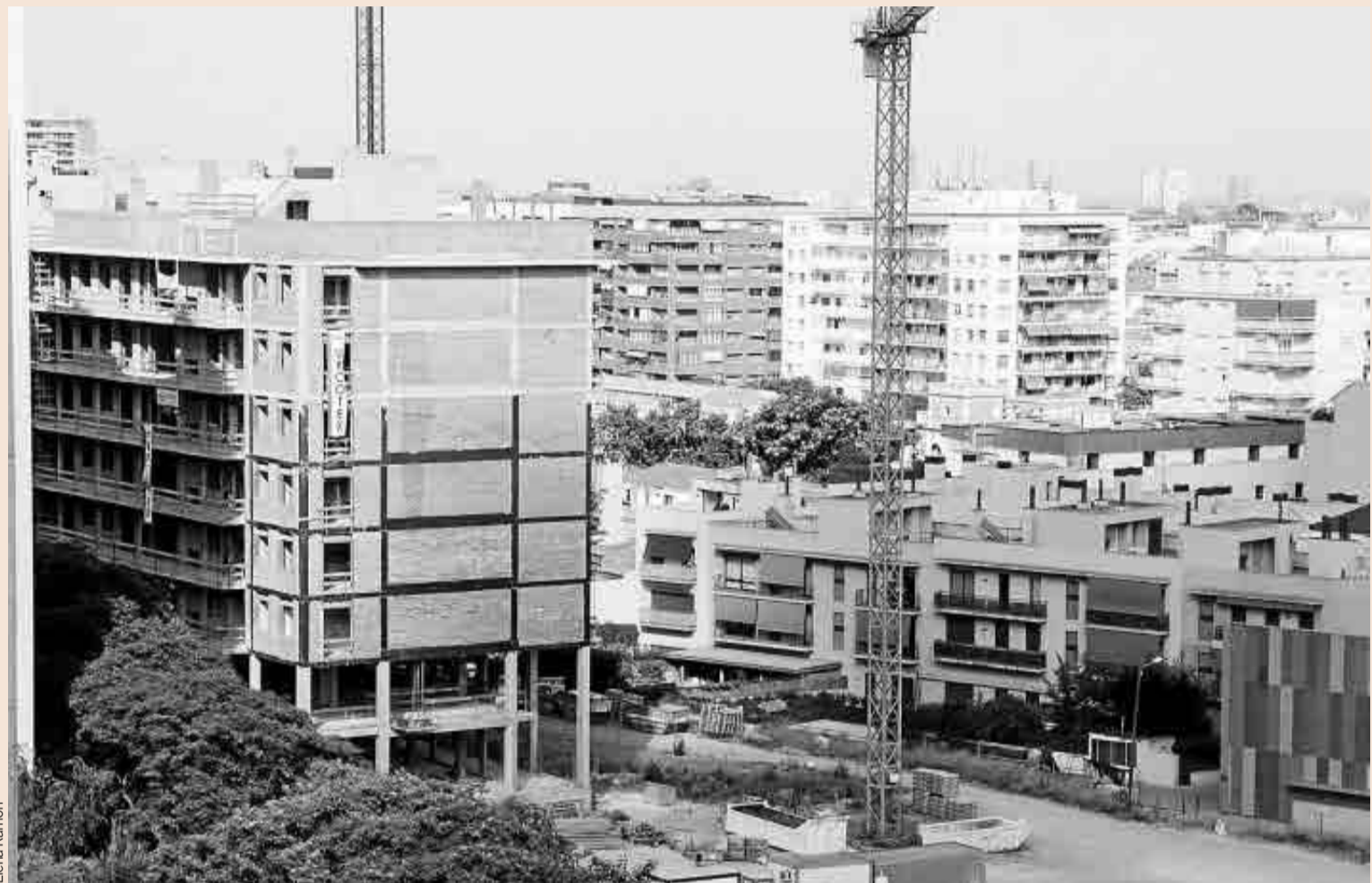
Elena Ramón Construcción de un bloque de viviendas en el barrio de Les Corts, en Barcelona.
