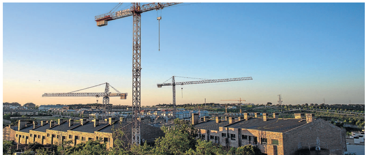
Viviendas en construcción en la localidad madrileña de Boadilla del Monte. ANTONIO LÓPEZ DÍAZ
