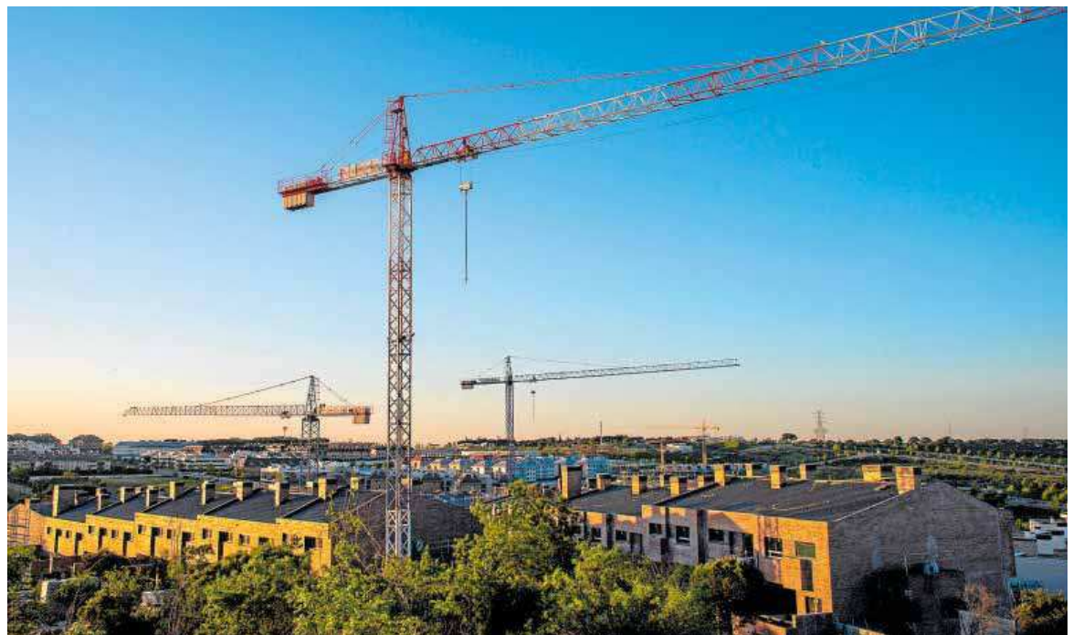
Una promoción de viviendas en construcción. ANTONIO LÓPEZ DÍAZ
