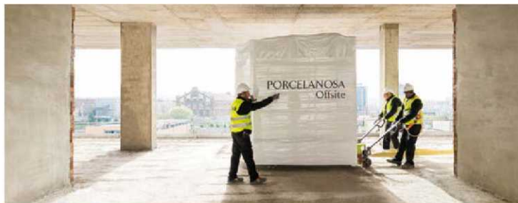
Colocación baño industrializado en proyecto.
