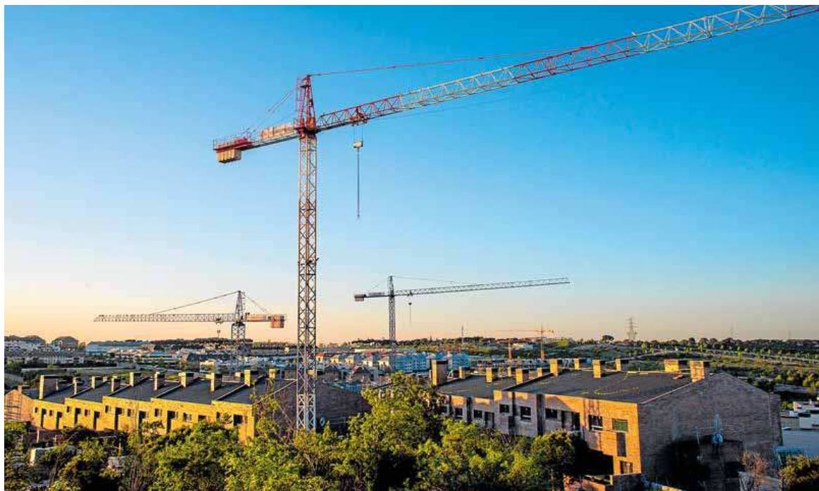
Una promoción de viviendas en construcción. ANTONIO LÓPEZ DÍAZ
