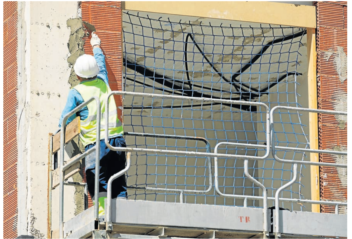
Un obrero durante la construcción de un edificio en Madrid | AEC
