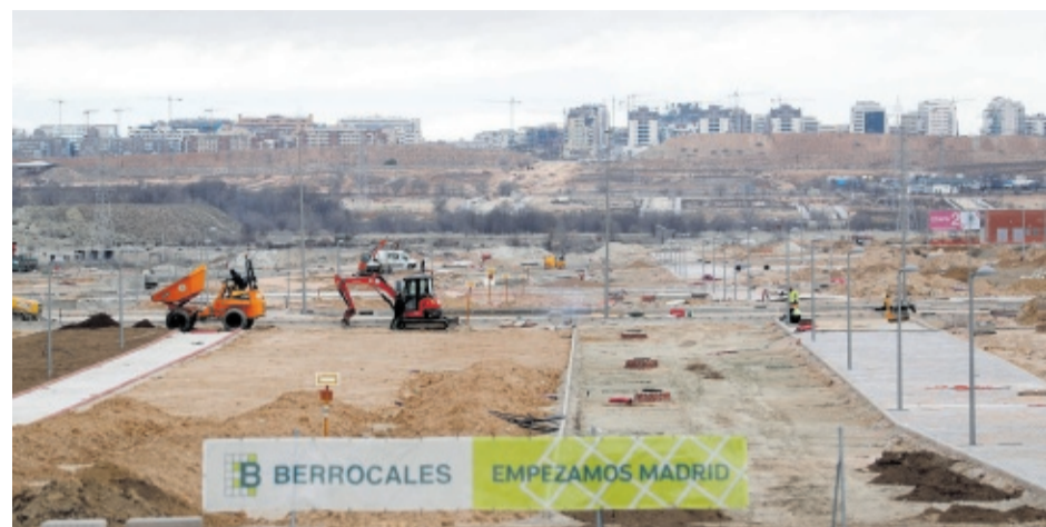
Obras de urbanización en el futuro barrio de Los Berrocales, en Madrid. PABLO MONGE
